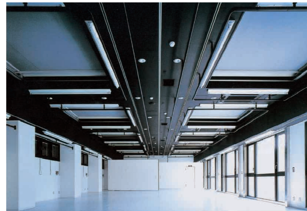
西沢学園 大阪コンピュータ 専門学校 (大阪府 1997) 設計:東設計 Nishizawa Gakuen Osaka Computer College, Osaka Designed by Azuma design [ERF-FD]
