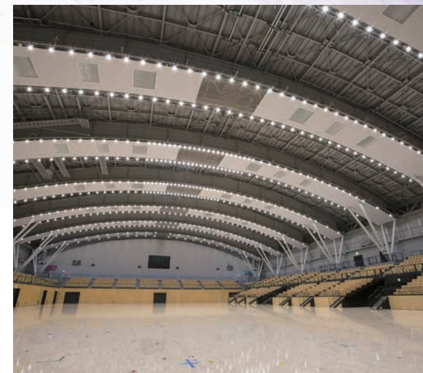
施工例・大型施設にも採用
